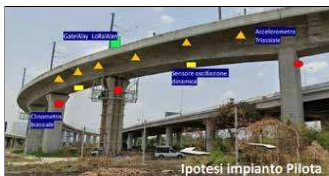
Figura 6 - esempio di disposizione dei sensori.
