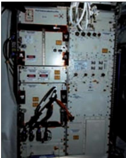
Figura 6 – EDR (European Drawer Rack) e FSL (Fluid Science Laboratory), per la conduzione di esperimenti scientifici in microgravità, Payload interni di Columbus modulo pressurizzato europeo, costruito da Thales Alenia Space
